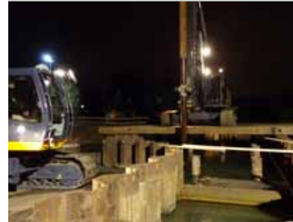
GESCHROEFDE STALEN BUISPALEN MET GROUTINJECTIE T.B.V. GEMAAL HARRIJN, MAARSSSEN
