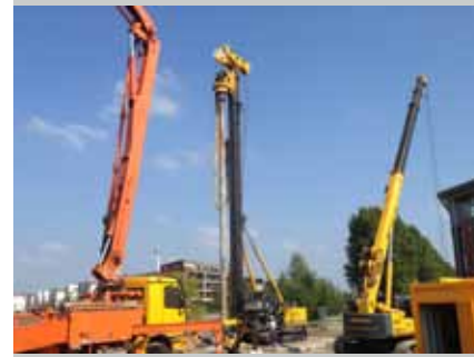
GRONDVERDRINGENDE BOORPALEN MET GROUTINJECTIE IJSELSTEIN
