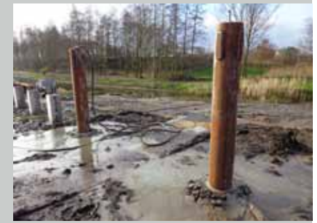
GESCHROEFDE STALEN BUISPALEN MET GROUTINJECTIE T.B.V. GELUIDSSCHERM LEUSDEN
