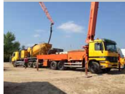
BETONMIXER EN BETONPOMP
