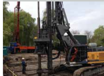
GRONDVERDRINGENDE BOORPALEN T.B.V. WONING VREELAND
