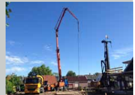
GRONDVERDRINGENDE BOORPALEN T.B.V. APPARTEMENTEN BRAKEL
