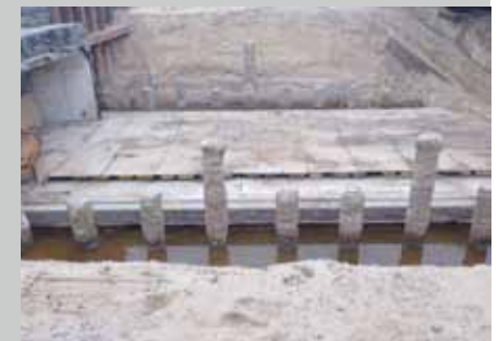
GRONDVERDRINGENDE BOORPALEN MET GROUTINJECTIE T.B.V. BRUG NOORDWIJKERHOUT
