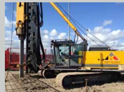
PREFAB HEIPALEN T.B.V. TENNISCLUB IJBURG, AMSTERDAM
