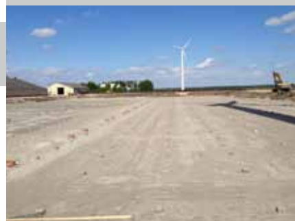
1.485 VERDIEPTE PREFAB HEIPALEN T.B.V. STAL ZEEWOLDE
