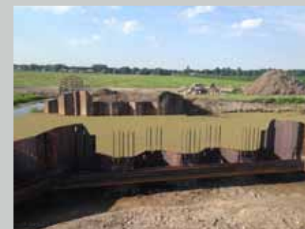
10 LANDHOOFDEN T.B.V. 5 LANDBOUWBRUGGEN VIERAMBACHTSPOLDER, TER AAR
