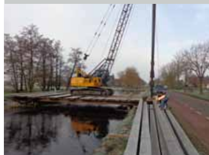
PREFAB HEIPALEN T.B.V. BRUG PORTENGEN
