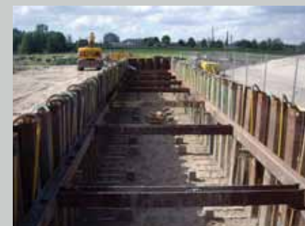
PREFAB HEIPALEN EN BOUWKUIP T.B.V. VEETUNNEL N201, AMSTELHOEK
